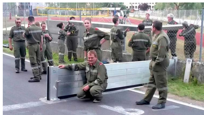
Aufbau des Hochwasserschutzes im Holzgraben, 14. Juli
